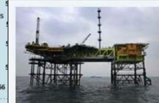
**Архангельское месторождение газа** расположено в 60 км от берега при глубине воды около 50 метров. Введено в эксплуатацию в 1992 году. Добыча ведется с нескольких стационарных платформ. С 2010 года месторождение дообустраивается. Установлена новая стационарная платформа БК-1, построен подводный газопровод и пробурено десять скважин.
